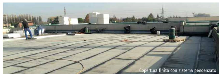
Copertura finita con sistema pendenzato
